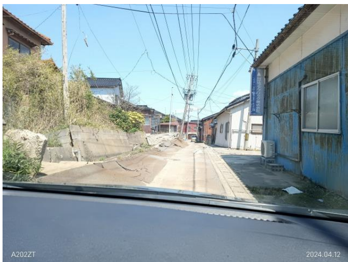
内灘町の被災地
