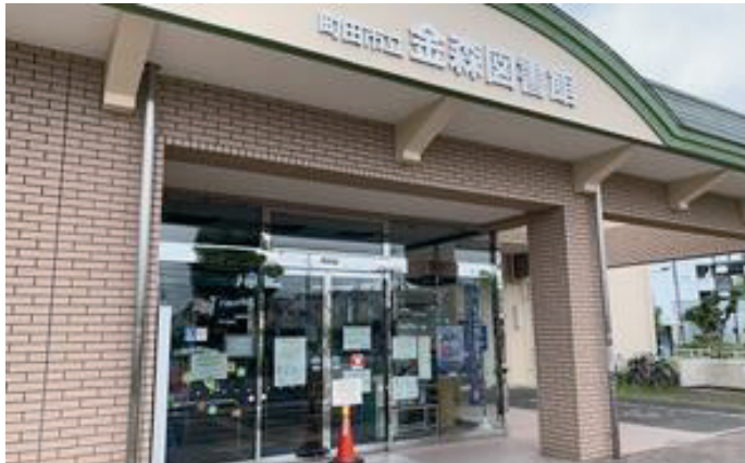
*閉館中の町田市立金森図書館：都営住宅に隣接した建物であり、鉄筋一部2階建の建物
