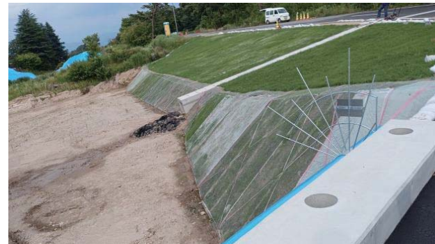
写真：崩壊した橋とのり面が全面改修中
